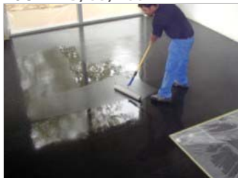
[ Foto: Concrete Masters ]
